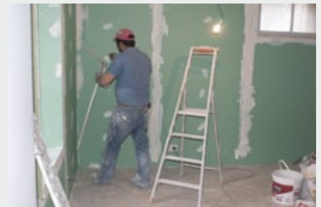
Extension du cabinet médical
