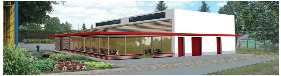
Les travaux du restaurant scolaire débuteront cette année.
