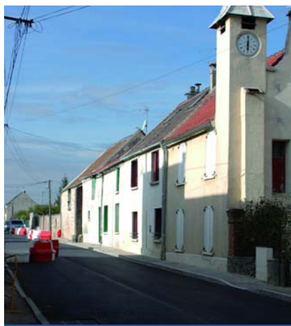
Refection de la chaussée et des trottoirs à Beaumarchais
