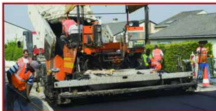
→ De multiples travaux et réfections de chaussées sont entrepris durant l'année
