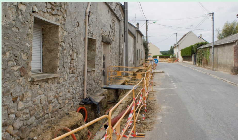
Enfouissement des réseaux à Beaumarchais
