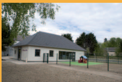
Des équipements à sécuriser
